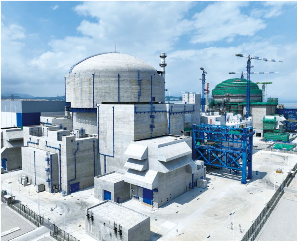
2024年9月27日，“华龙一号”漳州核电项目1号机组
